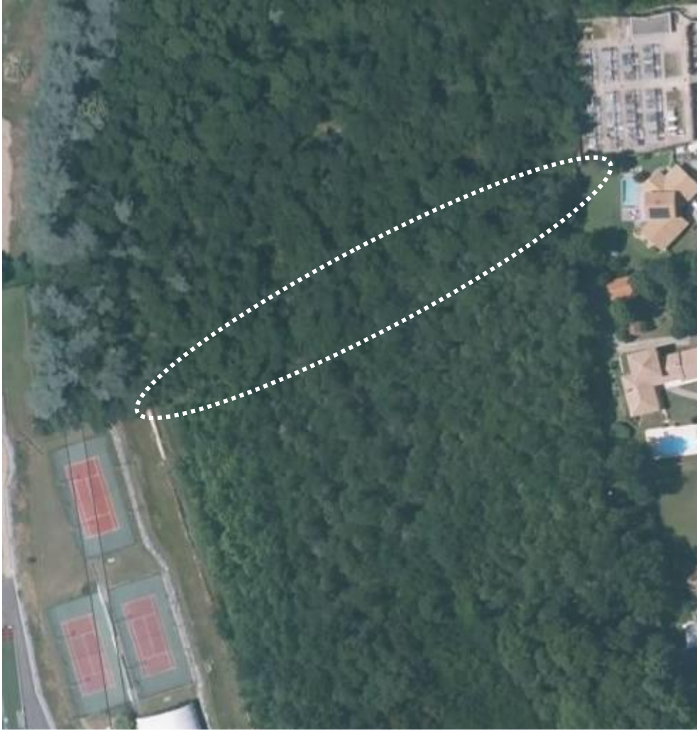
Mur entre le cimetière et les terrains de sports (caché sous la végétation)
